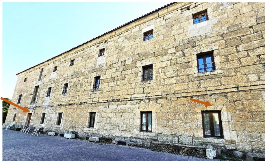
*Muro interno donde puede apreciarse el enganche de los retretes del piso inferior*
